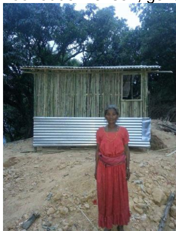
Voorbeeld van één van de bamboe-huizen die momenteel gebouwd worden.
